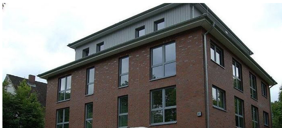
Ab Mitte des Jahres mit Leben erfüllt: Das neue Wohnhaus für Auszubildende in der Sengelmanstraße 37
